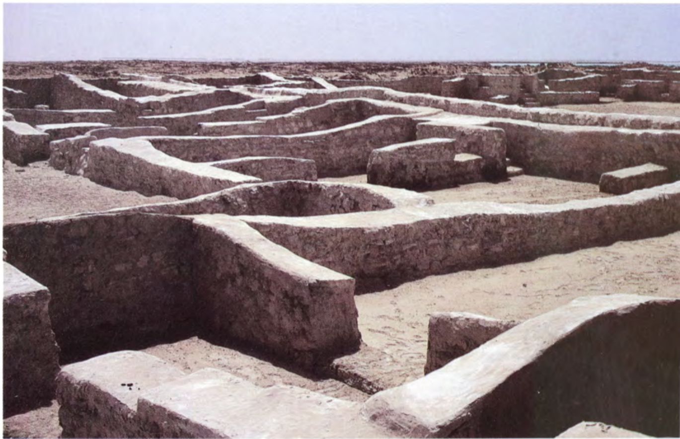
الزيارة - جدران البيت الشمالي الشرقي بعد إجراء أعمال الترميم
